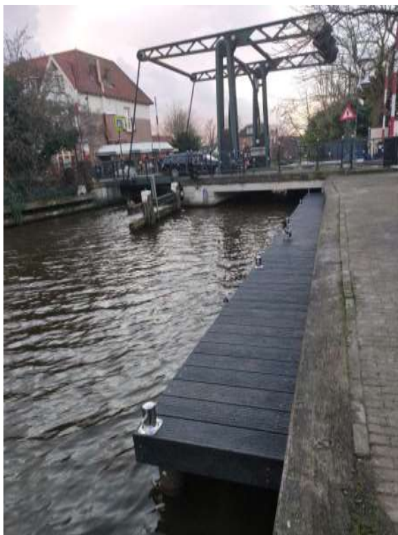
Aanlegsteiger centrum Abcoude
