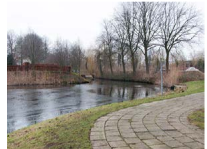
Zuid-oostelijke vestingwal van Oudewater: bastion met buitenwerk
