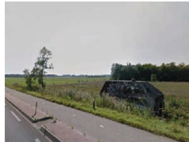
De Nieuwe Zuiderlingedijk met kasematten, Google earth
